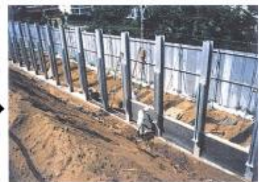
クレーンによる壁面板の建込み
