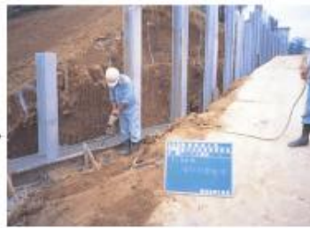
支柱根巻き及び基礎コンクリートの打設
