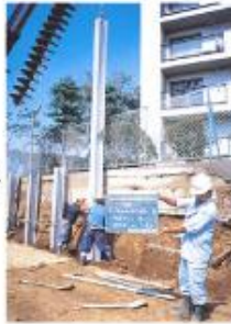
鉄骨支柱の建込み
