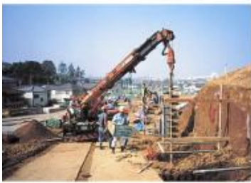
削孔機械による支柱杭基礎の掘削
