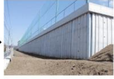
埋戻し後笠木コンクリートを打設し完成
